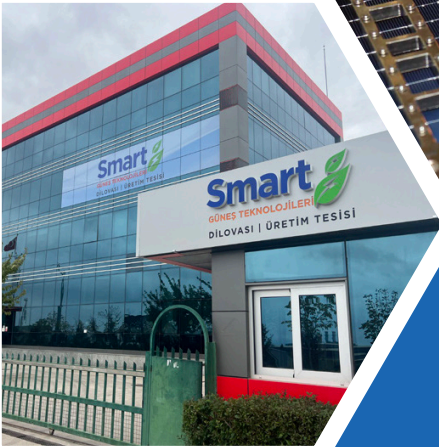
Dilovası Solar Module Factory
